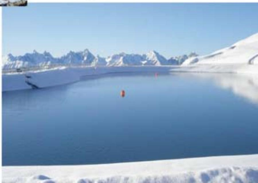
**Der vergrößerte Speicherteich am Sechszeiger:** Sein Inhalt wurde von 40.000 m<sup>3</sup> auf 105.000 m<sup>3</sup> erweitert, das entspricht der Kubatur von **105 Einfamilienhäusern** ! Der See hat eine Wasserfläche von 1,8 ha, die tiefste Stelle ist 10 Meter ! 4,2 ha Vlies und Folien wurden verarbeitet, 65.000 m<sup>3</sup> Erdmaterial bewegt, die Hälfte davon wieder eingebaut, der Rest auf Pistenflächen aufgebracht.
